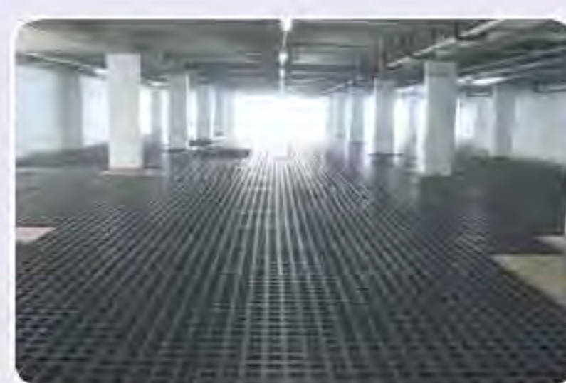
3. 콘크리트 타설 전
